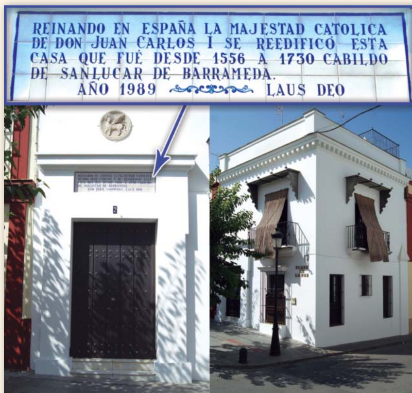
Antiguo Cabildo de Sanlúcar de Barrameda, con escudo y mosaico de azulejo que recuerda su época, donde asistía el Alcalde de la Mar con vara.
