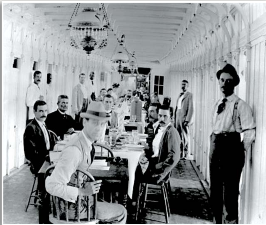
Esta fotografía del salón corrido del “Lula Prince” da idea del escenario de las desventuras y destrozos sufridos por el capitán Newcomb. Las puertas a banda y banda son accesos a camarotes de pasaje, y en uno de los extremos del local (probablemente a popa) debería haber un salón abierto reservado para señoras. En la esquina superior derecha se aprecian las claraboyas que dan a la “Cubierta Texas”, suministrando luz natural; el individuo en primer plano (¿el “clerk”?) parece sobreactuar haciendo horas extra en su escritorio a la hora de comer ¡y sin quitarse el sombrero! (Thomas H. & Joan Gandy Photographic Collection)
