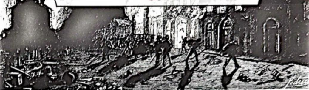
**E**l terremoto provocado por la explosión de más de treinta toneladas de dinamita transportada por el Cabo Machichaco agrietó muchas paredes maestras y derribó tabiques y tejados en multitud de edificios. Según la inspección llevada a cabo por los arquitectos municipales sufrieron importantes desperfectos ciento once casas, de las que veinticinco se declararon en estado de ruina inminente, además de las directamente demolidas por el estampido en el frente de Calderón de la Barca.
